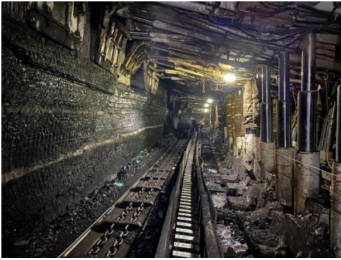
Resim 1. GLİ yeraltı üretim tesisi
