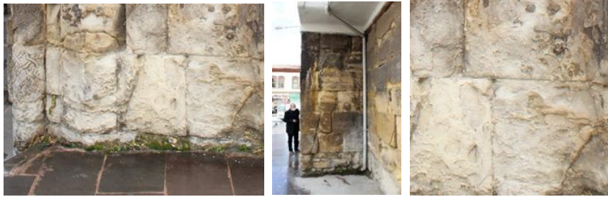
Fotoğraf 18: Taç Kapı, Sağ Taraf, Tuzlanma
