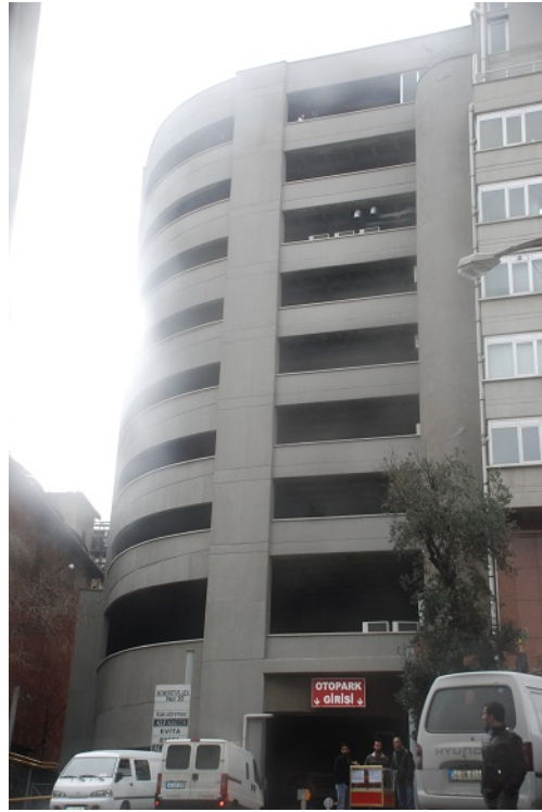
Şekil:17 Silahşör Caddesi'nin Birahane Sokağına açılan köşesinde yer alan katlı otopark.
