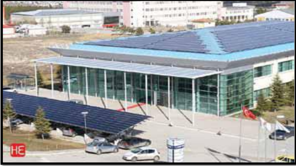
Şekil 9: Ankara'daki Halk Enerji Ltd. tarafından kurulan 420 kW'lık grid conncted fotovoltaik sistem.
