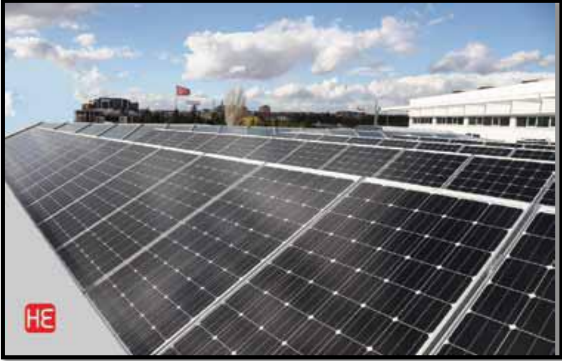
Şekil 13: Eskişehir’de Halk Enerji Ltd. tarafından kurulan 95 kW’lık grid-connetted fotovoltaik sistem.
