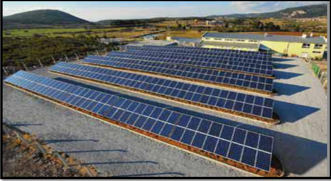
Şekil 11: Muğla'daki Anel Enerji Ltd. tarafından kurulan 105 kW'lık grid-connected fotovoltaik sistem.
