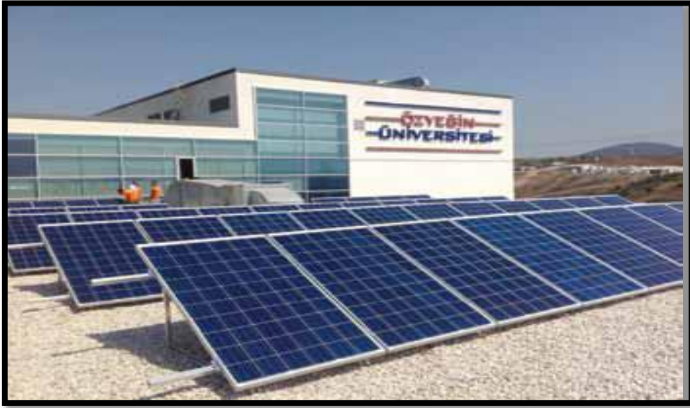
Şekil 8: İstanbul'da Özyeğin Üniversitesinde Mühendislik Fakülte Binası çatısına kurulan 13 kW'lık grid-connetted fotovoltaik sistem.
