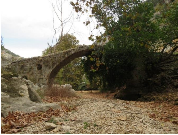
Fig. 12. Sömek Köprüsü'nün memba cephesi
