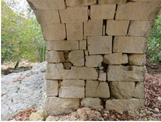
Fig. 9. Tonz içi ve hatıl deliklerinden ayrıntı
