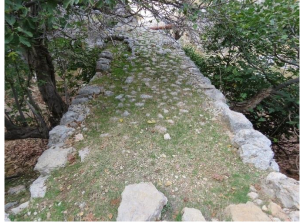
Fig. 13. Köprü tabliyesinin güneyden görünümü
