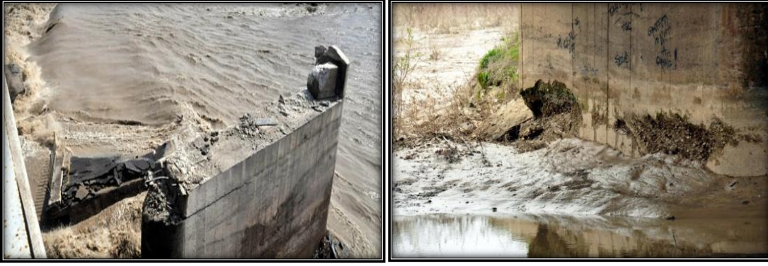
Şekil 4. Köprünün taşıyıcı ayakları ve temelleri (KGM, 2012)
