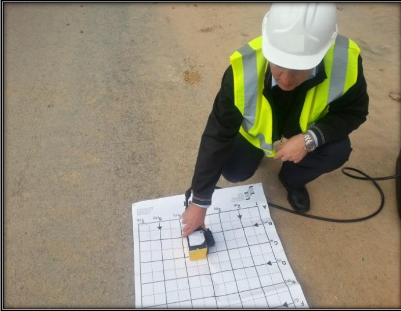
řekil 9. TR HF (2 GHz) Anteni kullanılarak köprü üzerinde GPR arařtırması
