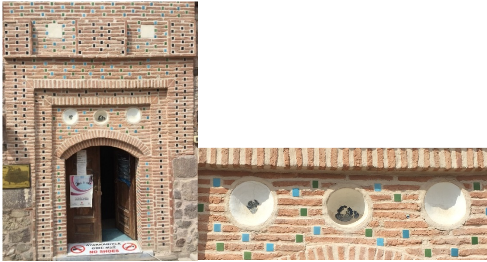
Resim 4. Arslanhane Cami Doğu Kapısı
