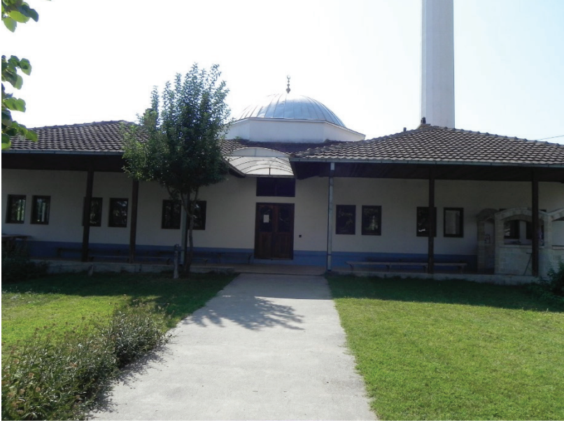
Resim 15. Yakova, Rugova Köyü, Hasan Ağa Camii, kuzey cephe.
