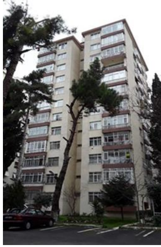
Şekil 4. Kaşaneler Sokak'tan 1976 yapımı apartman (Webgis Kadıköy Görüntüsü, 2022)
