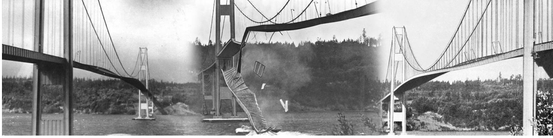
Şekil 1. Tacoma Asma Köprüsü'nün rezonans etkisiyle yıkılması [2]
