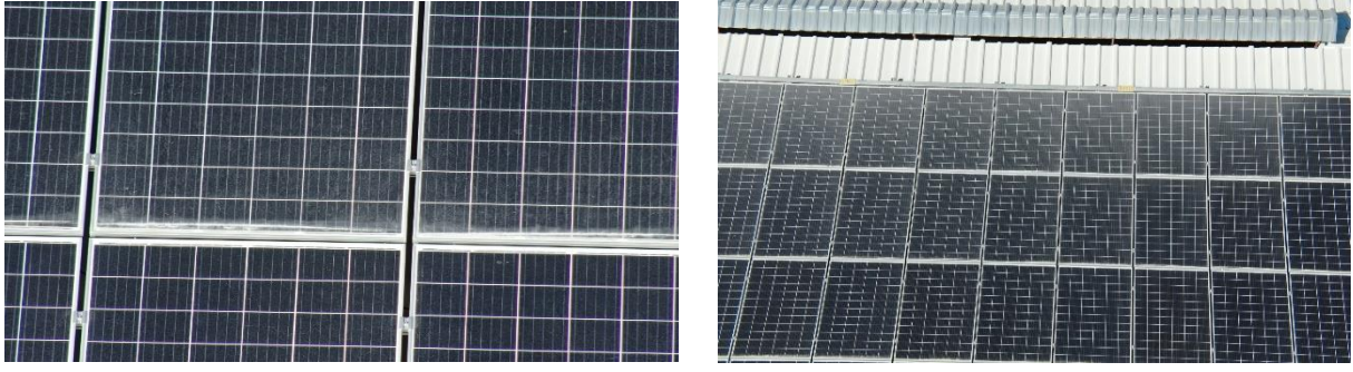
Şekil 8. 600 kW güneş enerjisi sisteminin kirlilik resimleri
