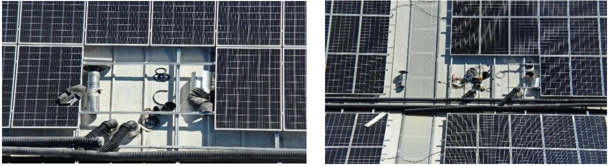
Şekil 9. 600 kW güneş enerjisi sisteminin gölgeleme resimleri
