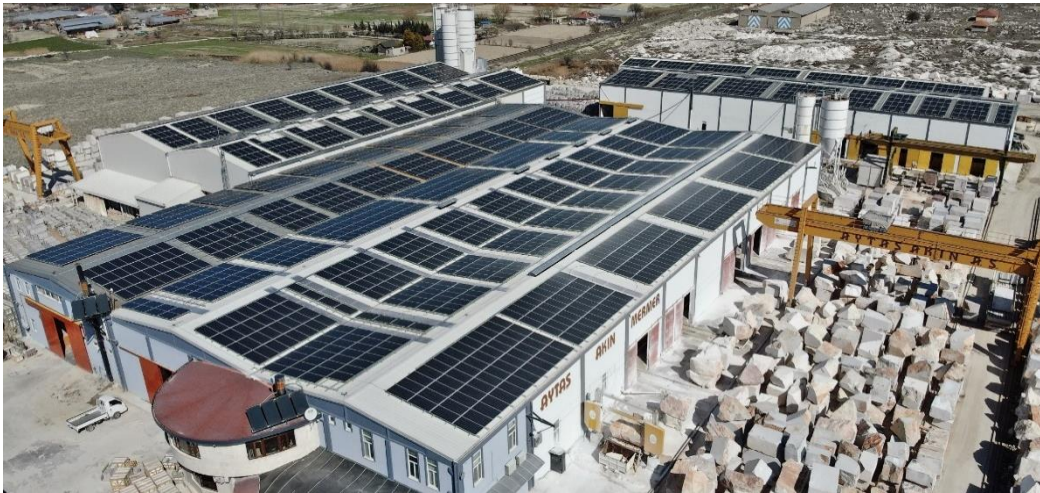
Şekil 4. Drone tarafından çekilen 600 kW GES görüntüsü
