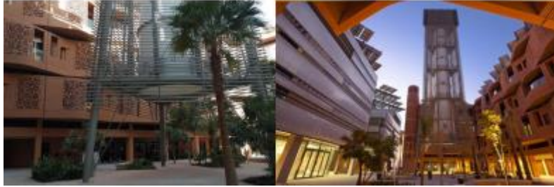
Şekil 20. Masdar Enstitüsü binasından (Abu Dabi) rüzgâr kepçesi örneği (Melikoğlu 2018)
