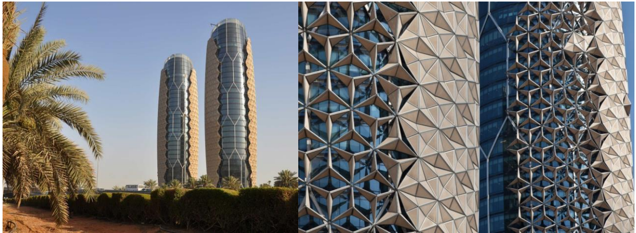
Şekil 4. Al Bahar Towers hareketli gölgeleme elemanı tasarımı (Cilento, K., 2012)
