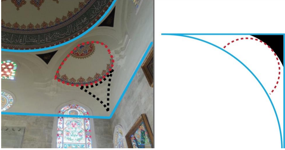
Şekil 2. Solda mavi hat ana kubbe ve duvarlar, kırmızı hat yarım kubbe kemerleri, siyah hat pandantifi temsil etmektedir. Sağda ise aynı elemanların plan kesit görünüşü bulunmaktadır.
