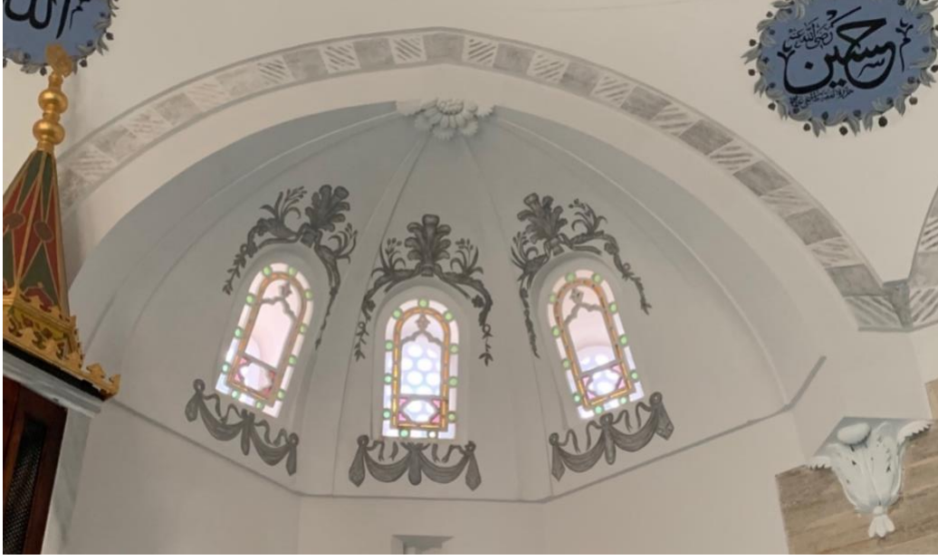
Şekil 11. Rüstem Paşa Camisi güneydoğu tromp pencerelerinden dış duvardaki şebekelerin görünümü
