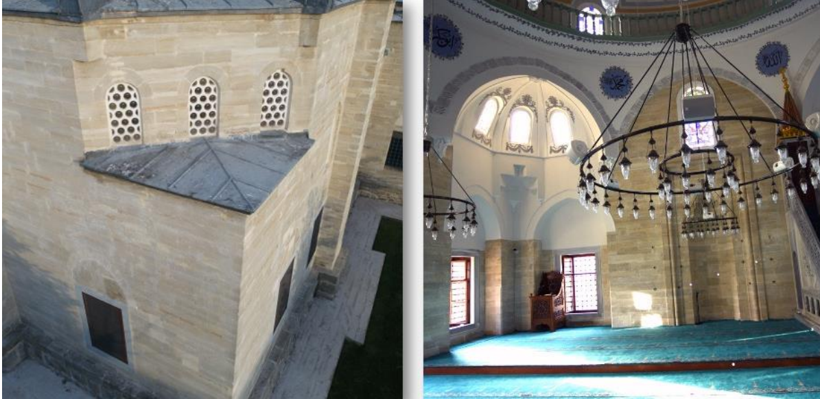
Şekil 12. Tekirdağ Rüstem Paşa Camisi güneybatı trompu iç ve dış görünümü
