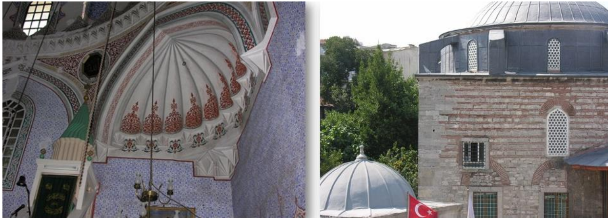
Şekil 8. Haseki Hürrem Sultan Camisi'nde trompun yapı içinden ve dışından görünümü
