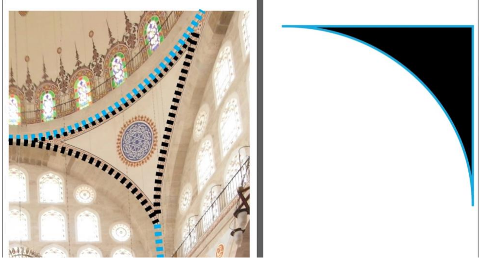
Şekil 3: Solda mavi hat kubbe ve duvarlar, siyah hat da duvara bağlanmak için ihtiyaç duyulan pendantif. Sağda aynı elemanların plan kesit görünüşü.
