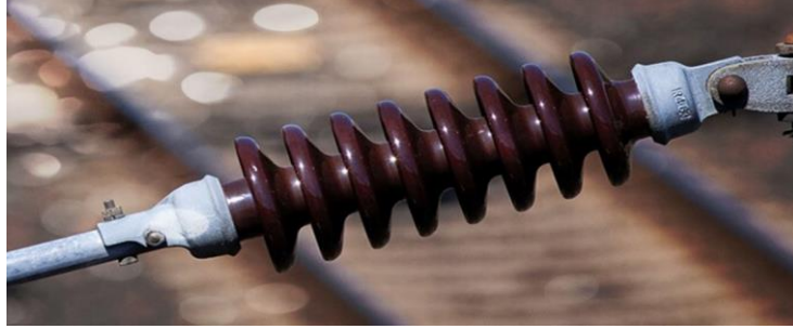
Şekil 1. Seramik izolatör [2]
