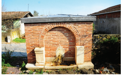
Fot. 13: Güney Cephesi
