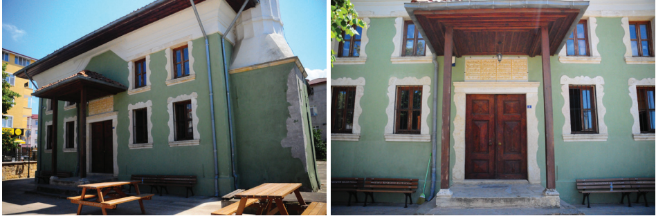
Fot. 9: Kandıra Sultan Orhan Camii Kuzey Cephesi Genel Görünümü
