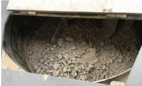
Şekil 5. Kuru malzemelerin betoniyerde karıştırılması
