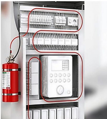
Şekil 11. Pano içi yangın söndürme sistemleri örnek uygulama
