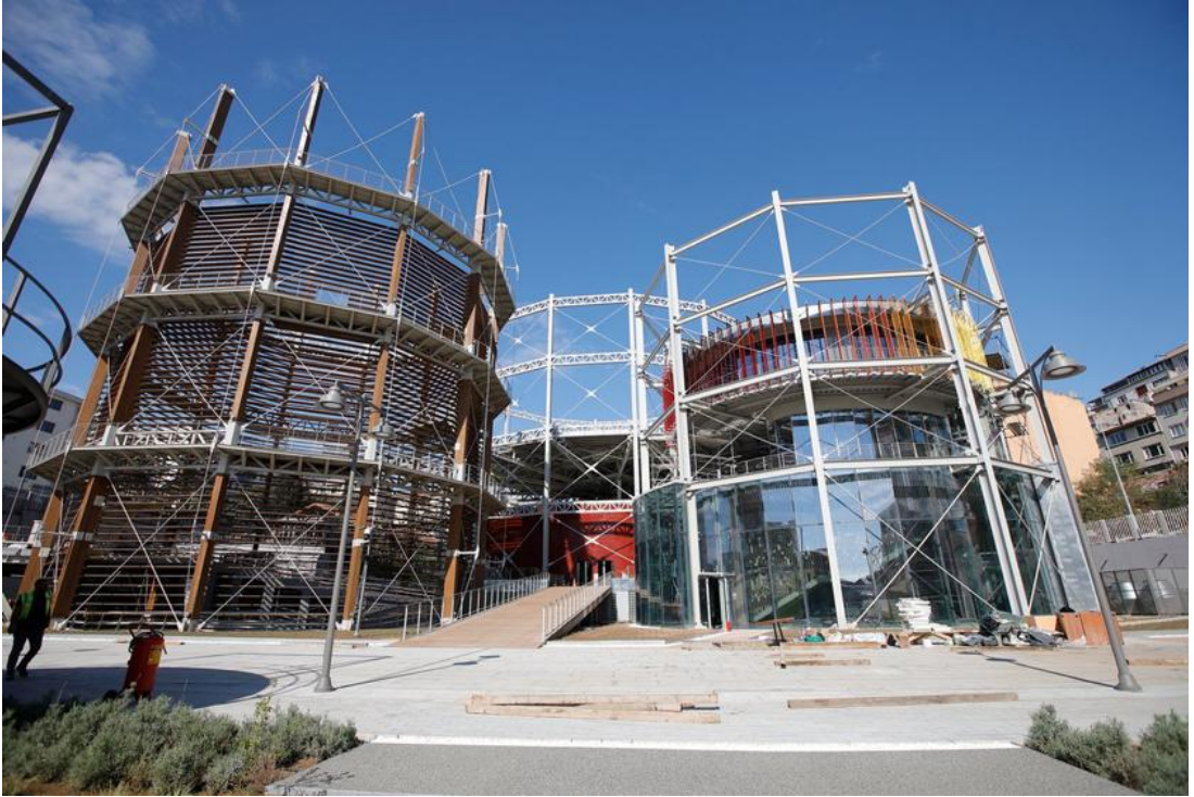
Görsel 9: Müze Gazhane restorasyonu kapsamında yeniden inşa edilen gazometreler, 2021.
