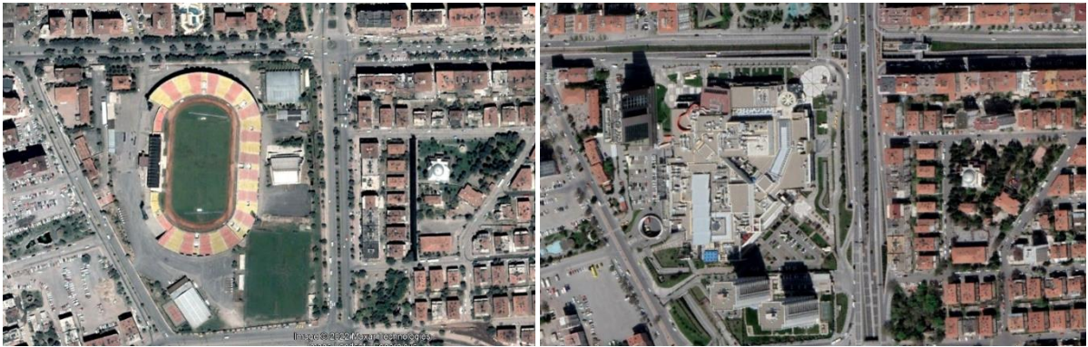
Şekil 8: The Kayseri Forum Residence ve Alışveriş Merkezi Hava Fotoğrafı Tarihsel Karşılaştırması
