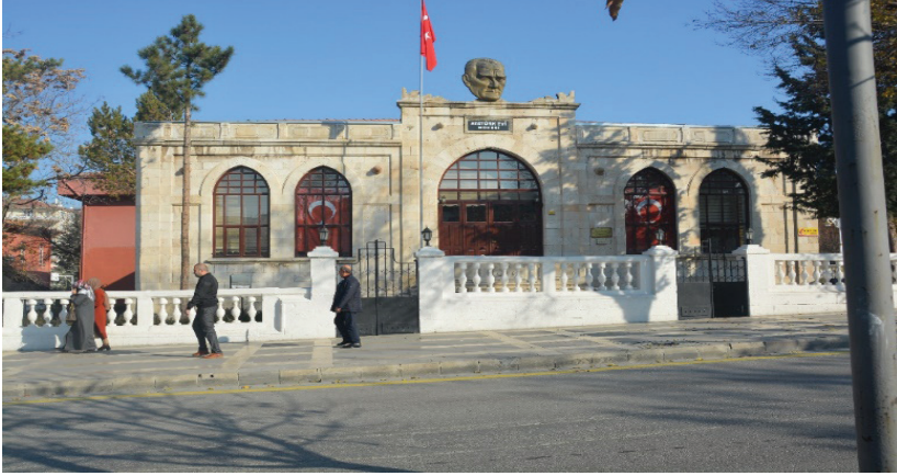
G. 7: Atatürk Evi Binası Giriş Cephesi (Sarı, 2019)
