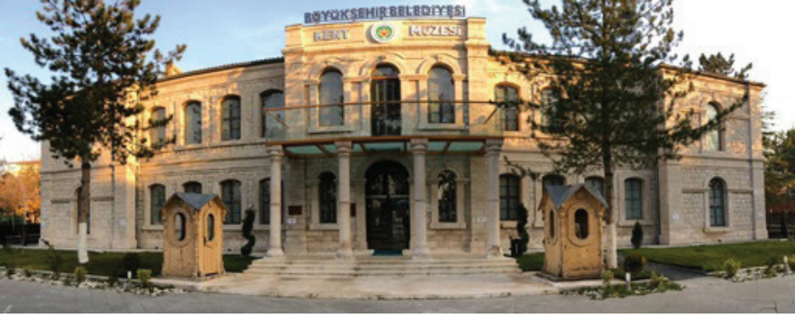
G. 3: Askerlik Şubesi (Kent Müzesi) Giriş Cephesi (Sarı, 2019)
