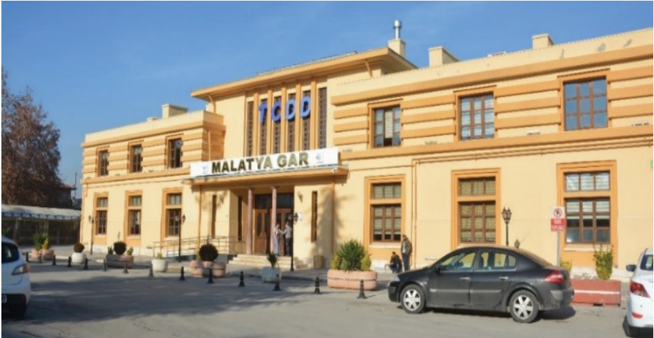
G. 11: Malatya Merkez Gar Binası Giriş (Sarı, 2019)
