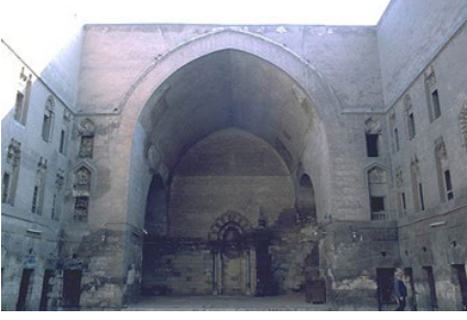
Fotoğraf 6: Sultan II. Baybars Hanqahı, Kible Eyvanı (Mescit)
