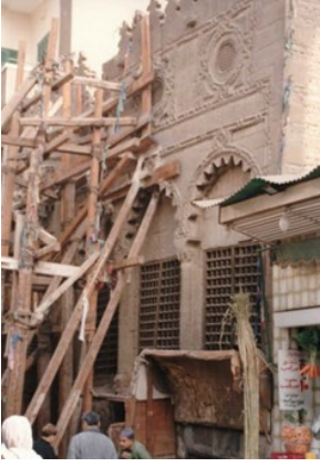
Fotoğraf 32: Abdurrahman Kethüda Zaviyesi Kuzeybatı Cephesi
