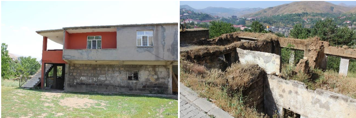
Resim 6. Geleneksel Bitlis evlerinde eklentilerden dolayı yapılarda oluşan bozulmalar
