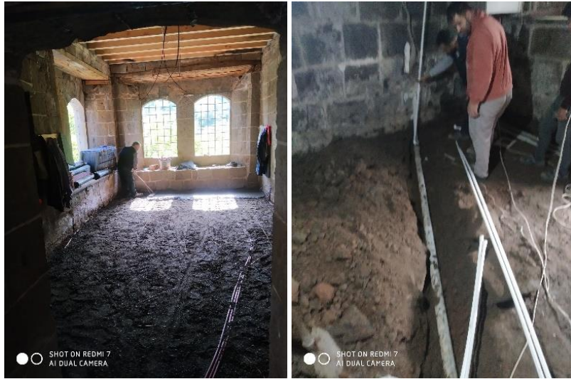
Resim 9. Alt yapı sorunları çözüm önerileri
