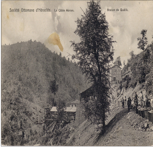
Fotoğraf 11. Gelik Havai Hat İstasyonu'na dekovil vagonlarıyla kömür taşınması (Salt Online, b.t. c / Coal transport to Gelik aerial ropeway station by lorries (Salt Online, n.d. c)
