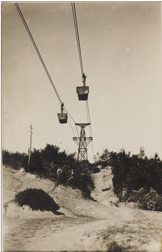
Fotoğraf 12. Gelik-Üzülmez (Asma) arasındaki havai hatla kömür taşınması (Salt Online, b.t. b / Coal transport by aerial ropeway between Gelik and Üzülmez (Asma) (Salt Online, n.d. b)
