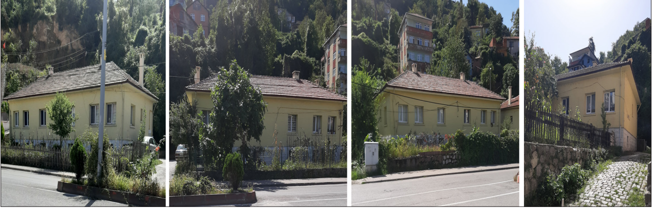
Fotoğraf 13. Kozlu istasyonuna ait dört adet çift lojman yapısı (Fotoğraflar yazarlar tarafından çekilmiştir, Eylül 2022) / Four semi-detached lodgements of Kozlu station (Photos were taken by the authors, September 2022)
