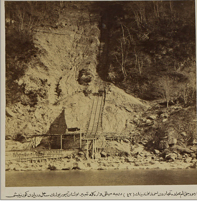
Fotoğraf 2. Eğimli varagele (İstanbul Üniversitesi II. Abdülhamid Han Fotoğraf Albümleri Dijital Arşiv, b.t. /a) / Inclined cableway (Istanbul University II. Abdülhamid Han Photo Albums Digital Archive, n.d. a)
