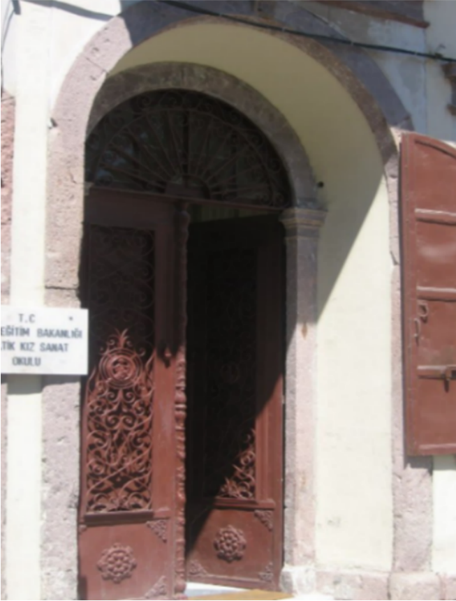
Şekil 7. Sanat Sokağı 166 ada 33 parseldeki yapının ana giriş kapısı ve penceresi (Anıtlar Kurulu Arşivi)
