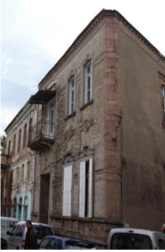
Şekil 28. Sanat Sokağı 176 ada 13 parseldeki yapının 2002 senesindeki cephe durumu (Anıtlar Kurulu Arşivi)
