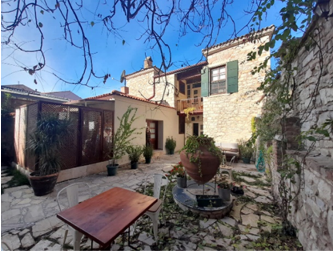
Şekil 23. Sanat Sokağı 176 ada 12 parseldeki yapının restorasyon sonrası durumu (Kutlukaya İnşaat Arşivi)
