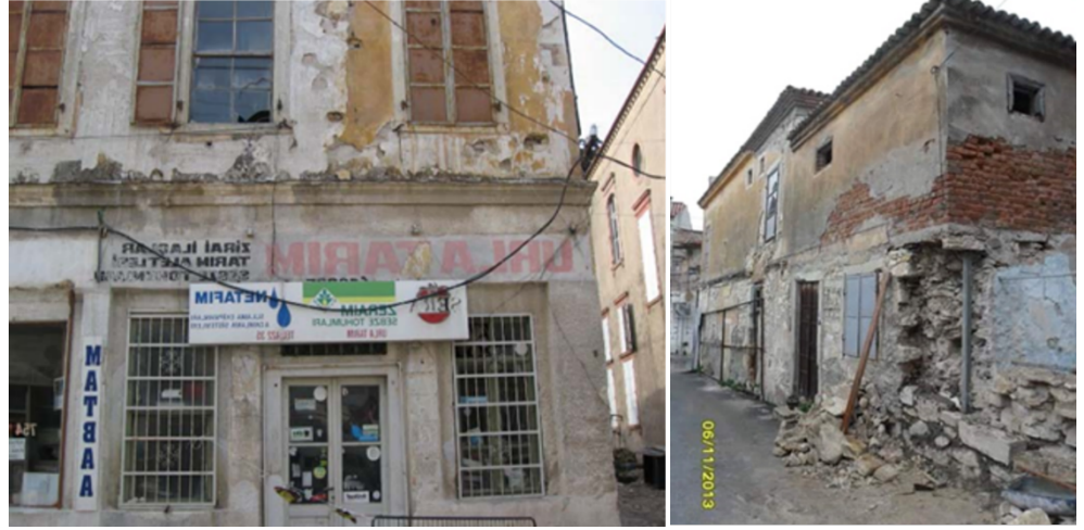
Şekil 21. Sanat Sokağı 176 ada 12 parseldeki yapının restorasyon öncesi cephe durumu (Kutlukaya İnşaat Arşivi)
