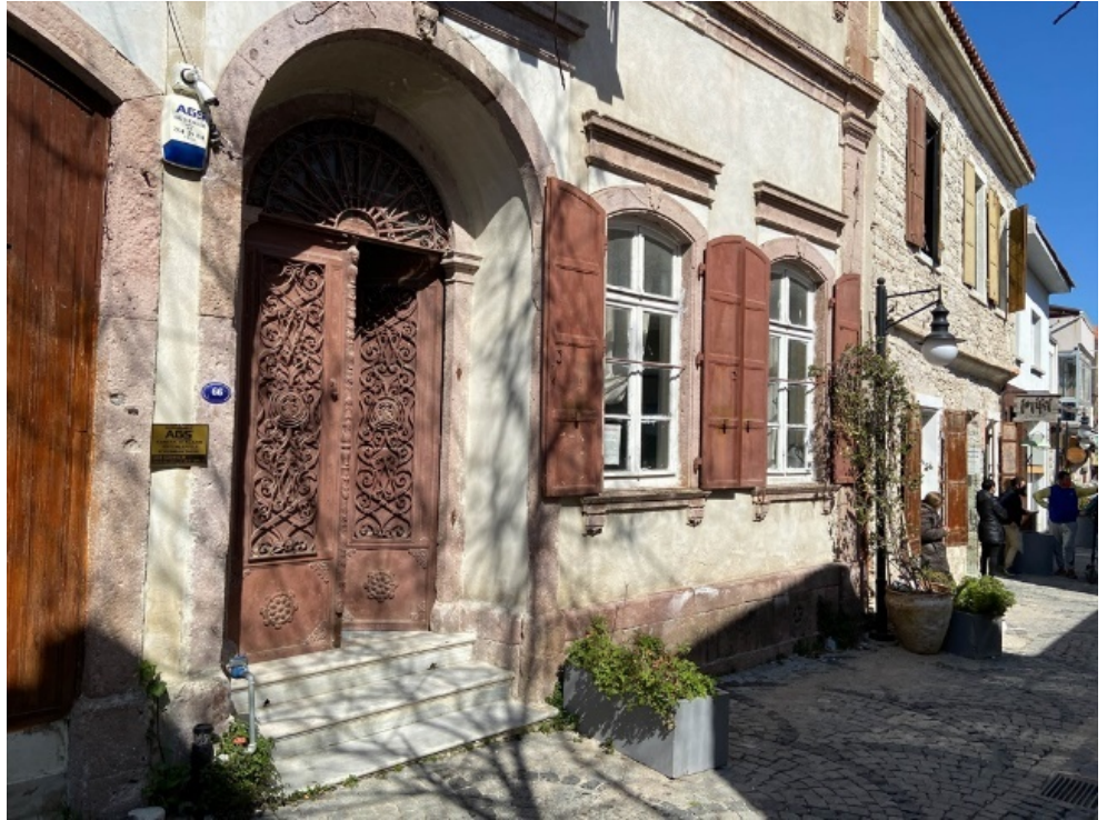
Şekil 10. Sanat Sokağı 166 ada 33 parseldeki yapının restorasyondan sonraki durumu (Visit İzmir, 2022)
