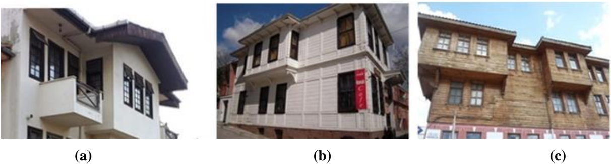
Şekil 18. Tekirdağ Kenti Süleymanpaşa İlçesi Ertuğrul Mahallesi (a) Sümbül Sokak; (b) Şeref Sokak; (c) Fulya Sokak'ta yer alan Tekirdağ geleneksel konutlarının saçaklarından örnekler (Kaynak: (a, b, c) Pala Aszöz, 2020).
