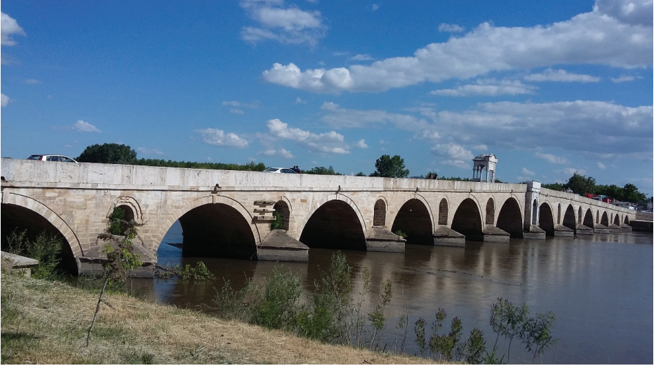
Fot. 1: Edirne Mecidiye köprüsü ve köprü köşkleri (N.Ç. Akçıl Harmankaya, 2020)
