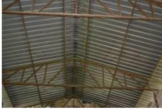
Şekil 15. Katholikonun günümüzdeki örtü sistemi (2022)
