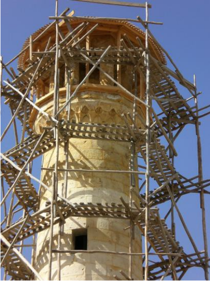
Foto. 25 Gaziantep Ali Nacar Camii Minaresi Detayı.
