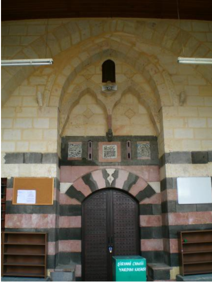
Foto. 3 Gaziantep Şirvani Camii Harim Taçkapısı.
