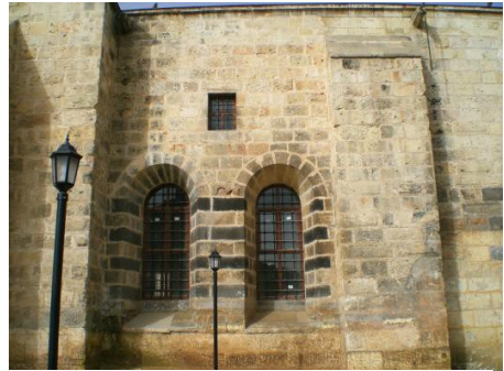
Foto. 18 Gaziantep Boyacı Camii Güney Cephesi Pencereleri.
