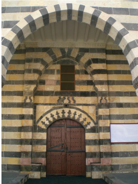
Foto. 6 Gaziantep Ağa Camii Harim Taçkapısı.
