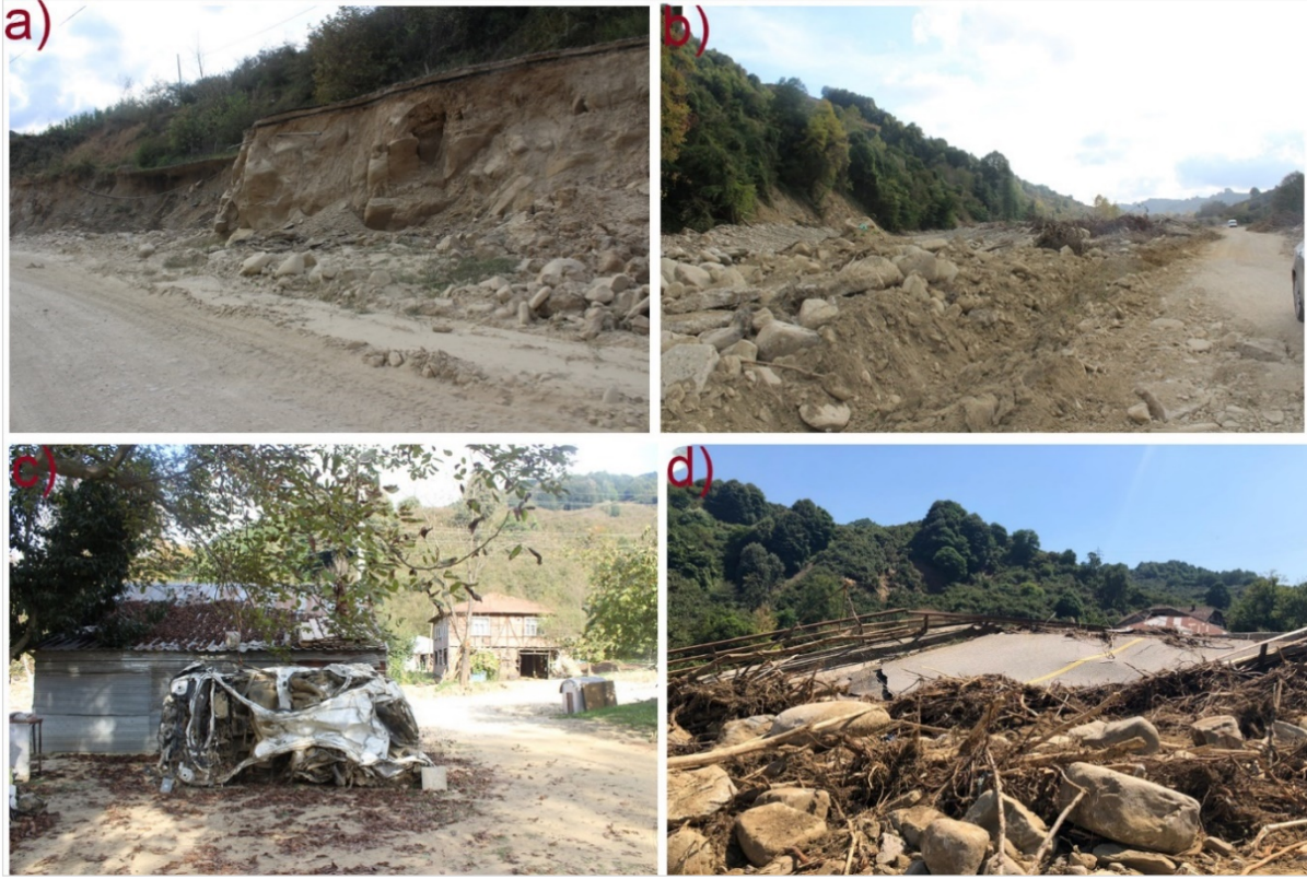
Foto 1. Sel-taşkın sırasında yollar (a,b), araçlar (c) ve köprüler (d) zarar görmüştür. Fotoğrafın kaynağı, Düzce AFAD İl Müdürlüğü, 2019'dur
