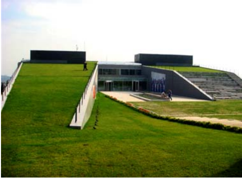
Resim 14. Turkcell Arge Binası-İzmit
