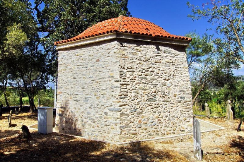
Foto. 6: Aydın Bey Türbesi Güneydoğu Cephe
