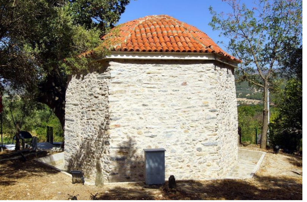
Foto. 5: Aydın Bey Türbesi Batı Cephe
