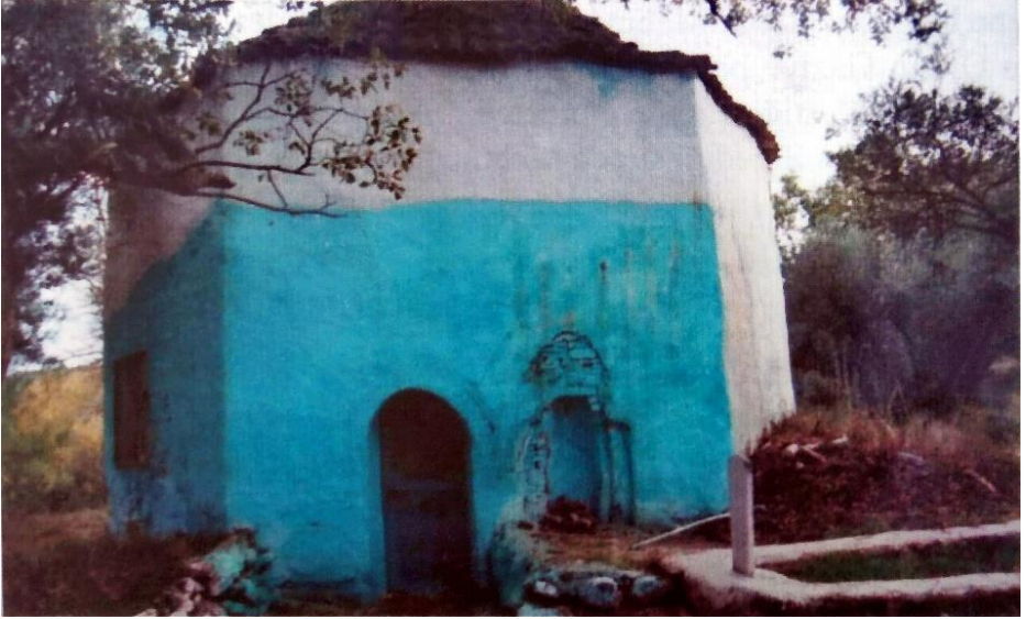
Foto. 4: Aydın Bey Türbesi Onarım Öncesi Genel Görünüm (Konukçu, 2016, s. 114)
