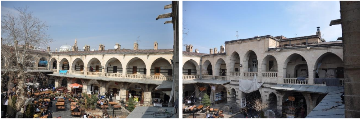
Şekil 2. Gümrük Hanı avlu cepheleri (Demir 2022)
