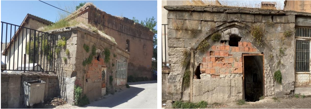
Res. 7-8: Hatun Çeşmesi Güneydoğu ve Ön Görünüşleri (Ş. Öztürk-2022)
