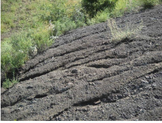
Şekil 7. Gölet etrafında görülen parmak erozyonu
