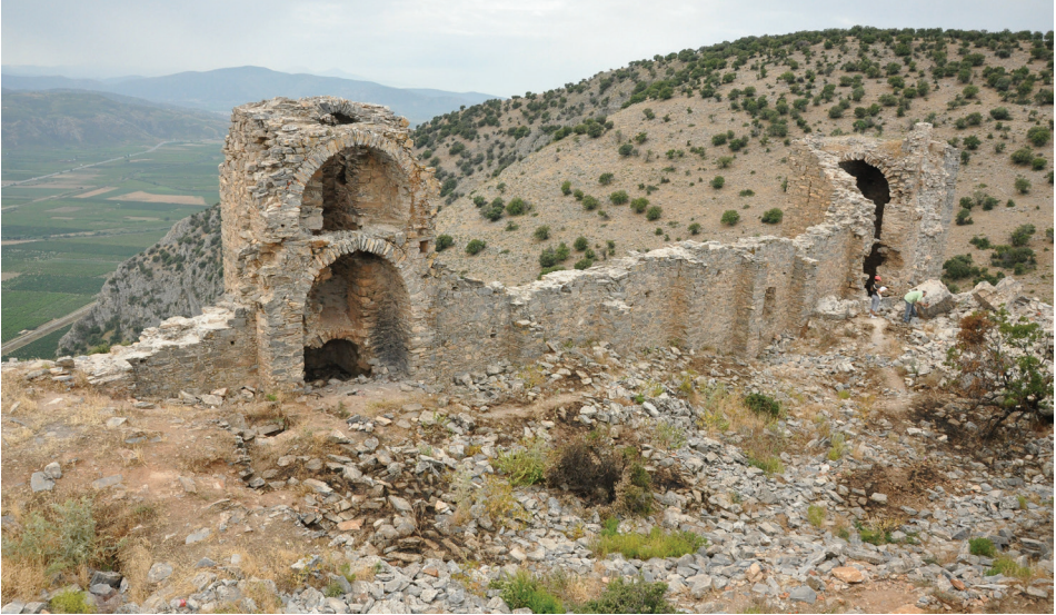
Resim 20 - İç kale güney beden duvarı ve kuleler.
