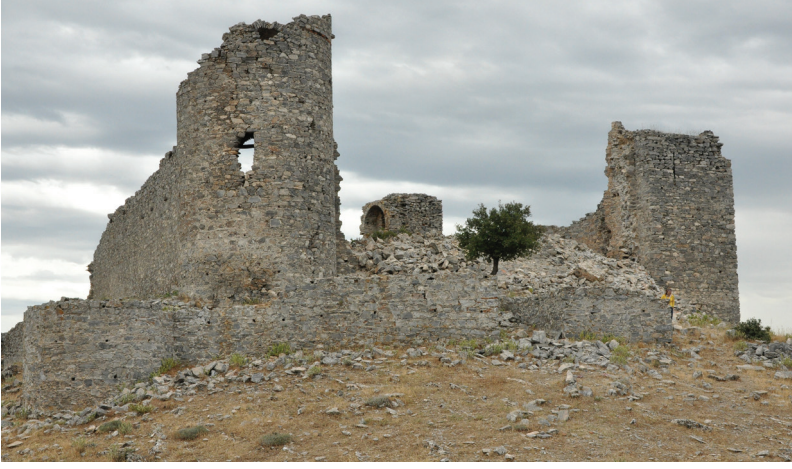
Resim 8 - İç kalenin batı beden duvarının 2005 yılında yıkıldıktan sonraki durumu. (Fot. Mimar H. Fevzi Çüçen, 2012.)
