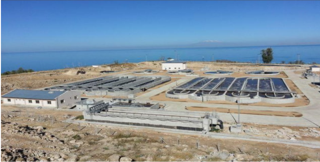
Şekil 1. Edremit evsel atıksu arıtma tesisi (Durak, 2020).
