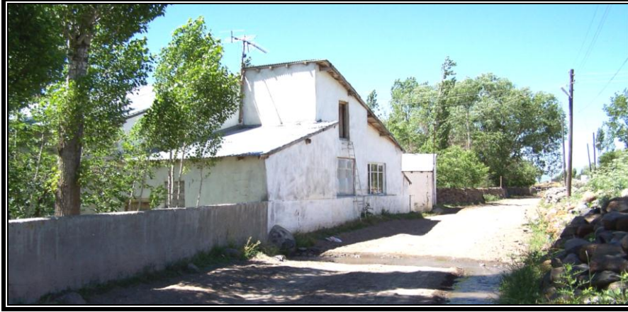
Fotoğraf 3. Ortabahçe köyünde ailenin kendi imkânları ile yaptığı betonarme bir konut.
