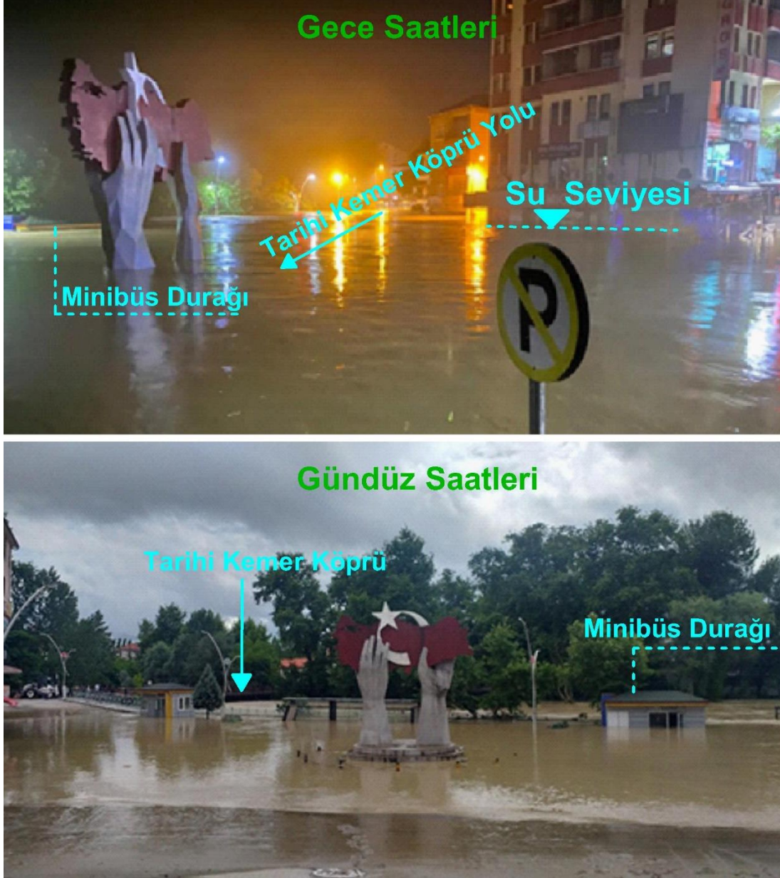
Şekil 5. Haziran 2022 sel baskını sonrası Bartın şehir merkezindeki ana geçiş güzergâhı olan tarihi Kemer Köprü mevkii
