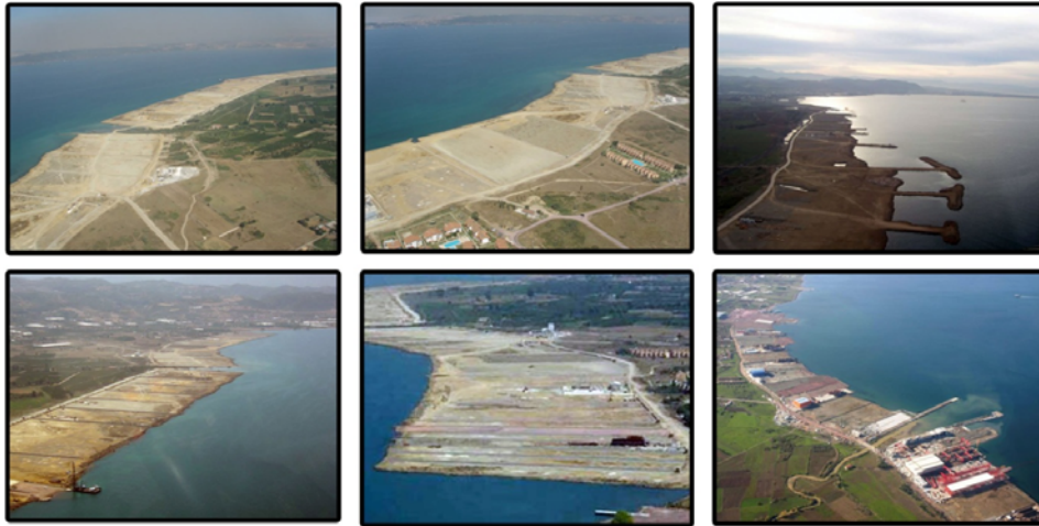
Foto 2: Hersek Deltası Batısındaki Tersane Alanı İçin Yapılan Dolgu Çalışmaları
