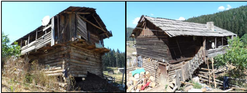
Fotoğraf 7. Uluyayla’daki en eski mimari tarzını temsil eden ve çantı ev tipi olarak tanımlanan, ağaçların köşelerinden yontularak birbirine geçirilmesiyle inşa edilmiş, üzerleri de bedavra ile örtülmüş yığma evlerden birer görünüm.
