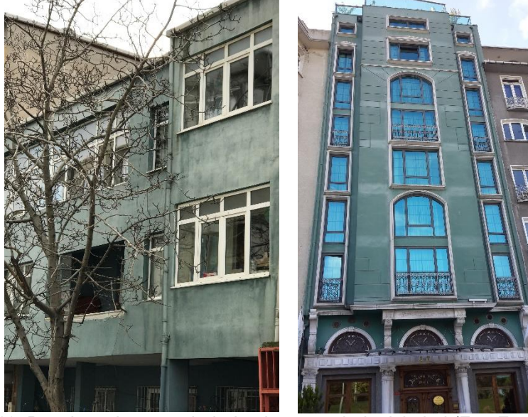
Şekil 16: Boyalı cephe yüzeylerinde oluşan renk değişimleri (Fot. Erturan B.)
