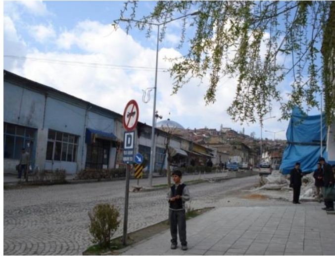
Foto. 4. Niteliksiz Demirciler Han Yıkılmadan Önce, 2006 (E. S. Akın Arşivi)
