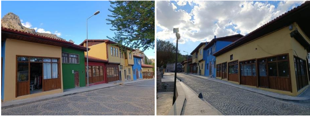
Foto. 49. Niteliksiz Yapılarda Cephe Sağıklaştırma, 2022 (A. Kalınbayrak Ercan Arşivi)
