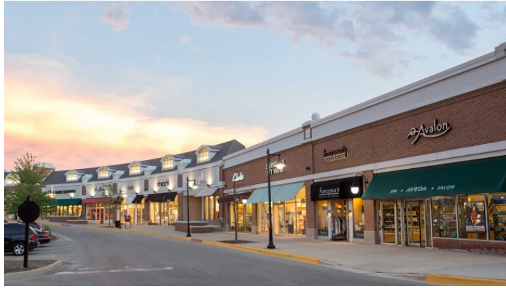
Fotoğraf 1. Illinois, Deer Park Alışveriş Merkezi'nin cephesi [30]
