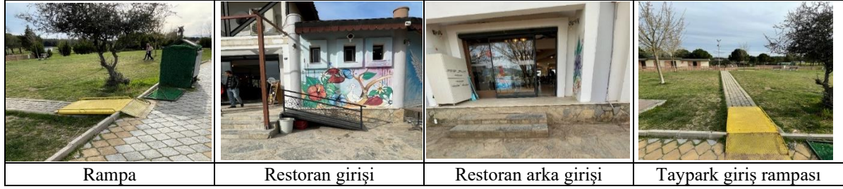
Şekil 10. Gölet Rekreasyon Alanı rampa ve merdivenler
