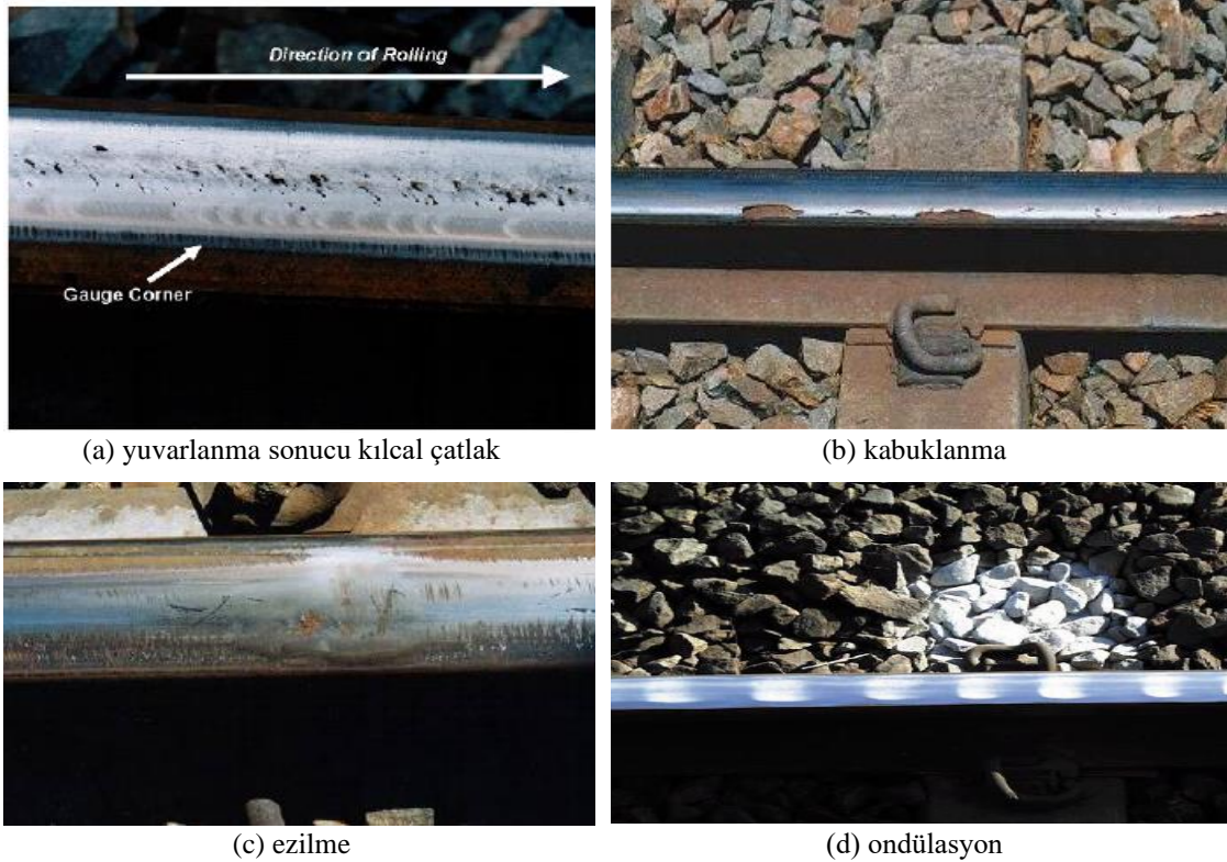
Şekil 2. Çeşitli ray yüzey kusuru örnekleri [10]
