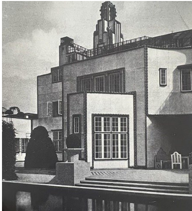
Şekil 7. Stoclet Palas Güney Cephe Pencereli Kesik V Formda Çıkma (Gresleri, 1985)
