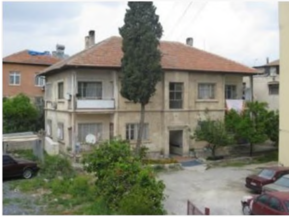
(a) 2 Nolu Yapı genel Görünüş
