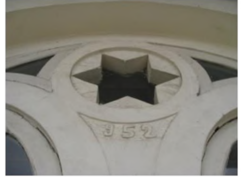
(b) Yapının yapım tarihini belirten yazı
