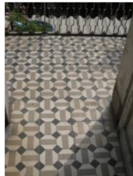
(f) Balkon döşemesi
