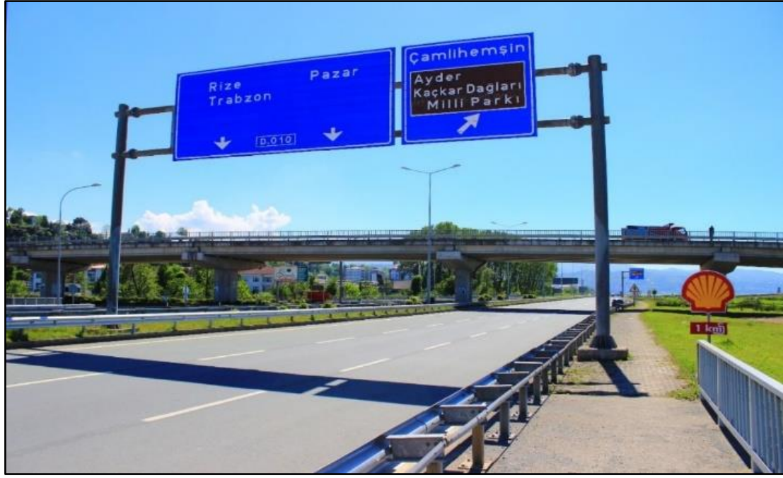
Fotoğraf 4. Ardeşen İlçe Merkezinden Çamlıhemşin'e Bağlanan Köprülü Kavşak.
