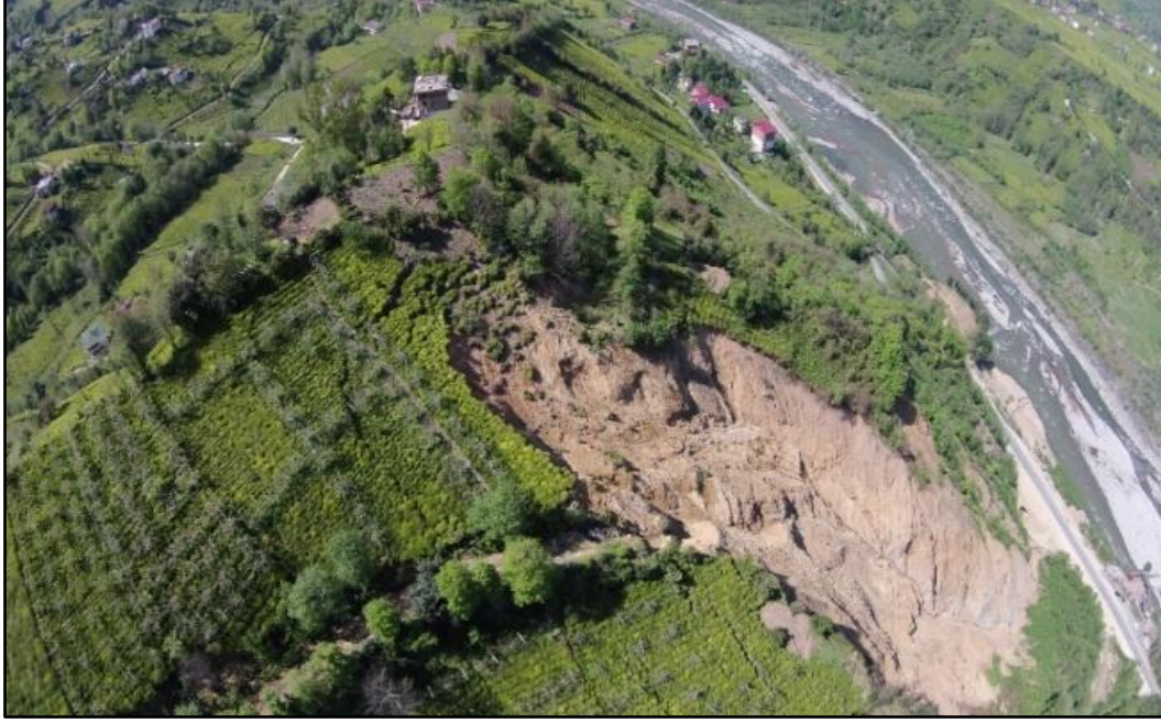
Fotoğraf 15. Heyelan Sonucu Zarar Gören Çay Bahçeleri.
