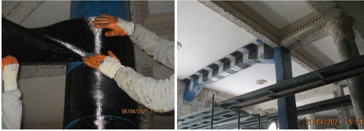
Şekil 8 - CFRP kumaşla betonarme elemanlarla güçlendirme uygulaması (Nisan 2021).
