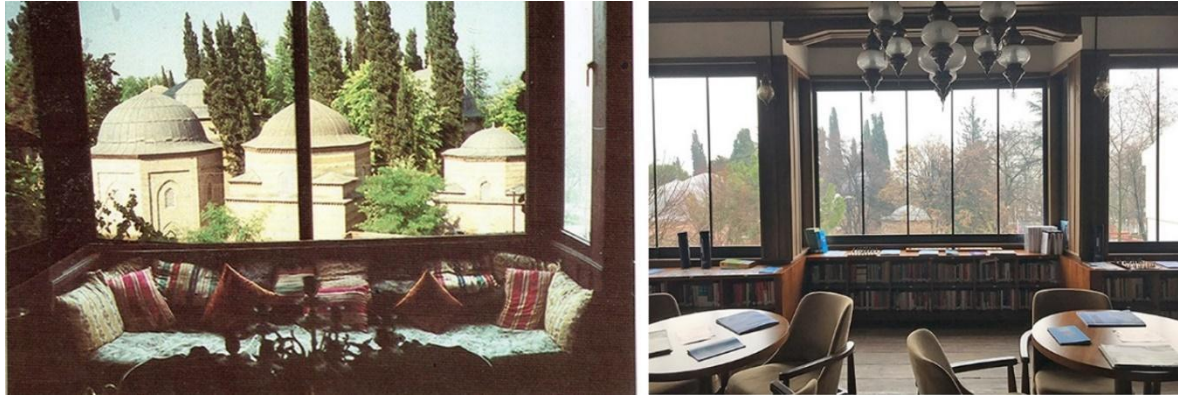
Görsel 33. Sofadaki Çıkma Değişimi, Solda 1998, Sağda 2021 Restorasyonu Sonrası.
