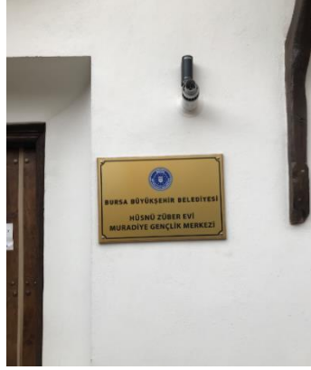
Görse 29. 2021 Restorasyonu Sonrası Cephedeki Kombi Baca Borusu.
