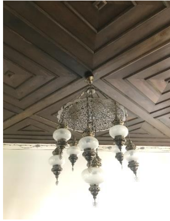
Görsel 24. 2021 Restorasyonu Sonrası Odanın Tavan Detayı.
